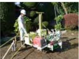
足利市福富町にて、住宅新築工事が始まりました。まずはSS方式による地盤調査からです。スクリューの付いた鉄の棒に重りをのせ、その棒の沈み具合で地盤の強さを計測します。調査結果により、弱い地盤と判定された場合には、表層改良や杭打ちなどの地盤改良工事が必要です。
