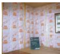
グラスウールの施工例
