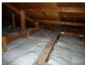
天井裏断熱材
